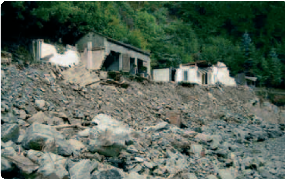
Abbildung 3-7: Großer Böschungs- abbruch am Prall- hang in Edle Krone (Wilde Weißeritz) (Foto: LTV, 2002)
